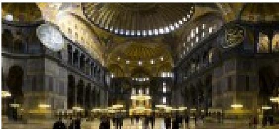
FIGURA 1: En Santa Sofía de Constantinopla, el empuje de la gran cúpula se descarga sobre las exedras semicirculares abovedadas dispuestas en los extremos de un diámetro de la cúpula. El espacio central parece, pues, expandirse en los dos sentidos del eje longitudinal, abriéndose y dilatándose. Los muros tienden a su disolución por la presencia de múltiples vanos y por el uso en la decoración de los muros de mosaicos dorados.
