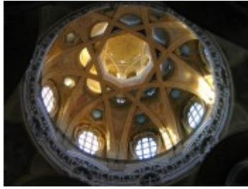
FIGURA 8: La Cúpula de la capilla de la Santa Sindone se levanta sobre tres pechinas, adaptadas a tres arcos y no a cuatro como es habitual, usándolas como transición entre la forma circular de la base del tambor de la cúpula. En su interior, con una decoración que usa exclusivamente elementos arquitectónicos, como molduras o ménsulas, Guarini consigue la impresión de la infinitud del espacio, efecto que la mayor parte de los arquitectos barrocos consiguieron mediante las pinturas ilusionistas.
